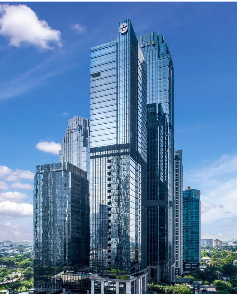
Kemewahan The Langham Jakarta terlihat dari arsitektur megahnya yang menjulang di kawasan SCBD.
